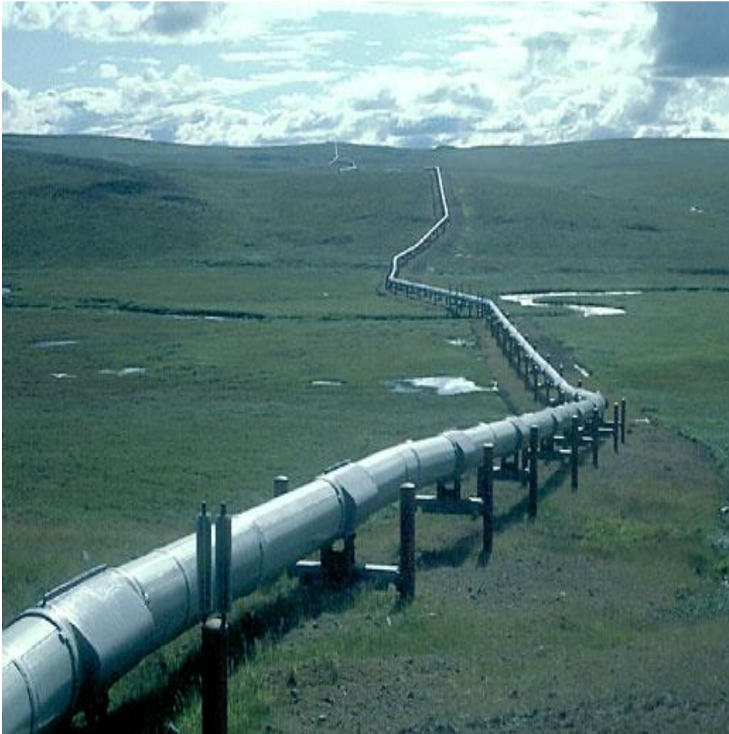
Gasdotto in Armenia
